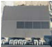
아산1 캠퍼스 태양광 발전 설비
