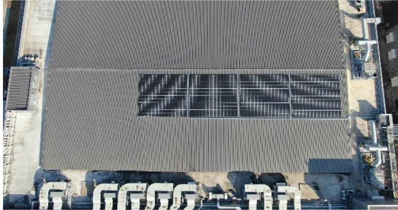
2022년 적극적인 온실가스 감축을 위해 아산 사업장 옥상에 태양광 패널을 설치하였습니다. 2023년 첫 가동 후 재생에너지로 사용 에너지를 대체하며, 에너지 소비량을 감축하고 있습니다. 하나머티리얼즈는 재생에너지 확보를 위해 지붕형 태양광 설비 증설을 추가 검토 중입니다.
